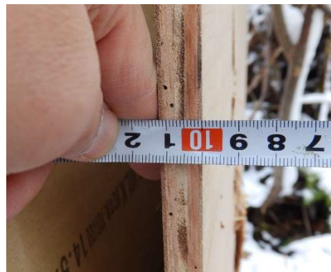
写真3：的紙を貼っていた型枠用合板（コンパネ）。厚さは12mm。
