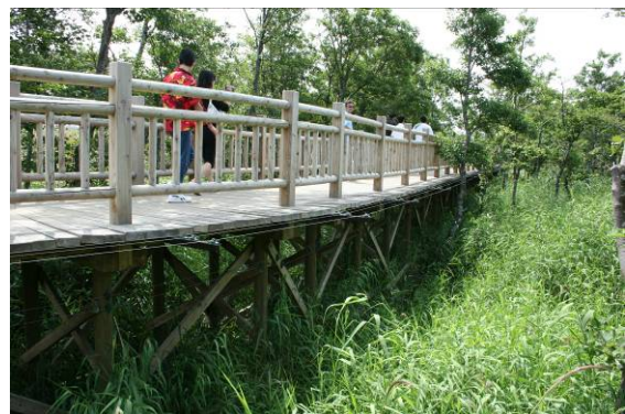
写真 6. 知床五湖に設置された電気柵付き高架木道
