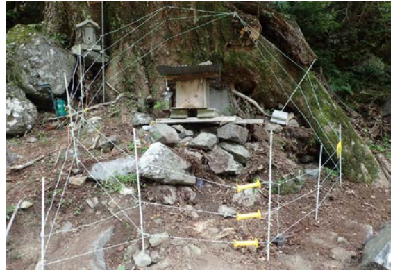
写真3：上部からの侵入を防ぐために電線を地面に水平に張った（地点2）。
